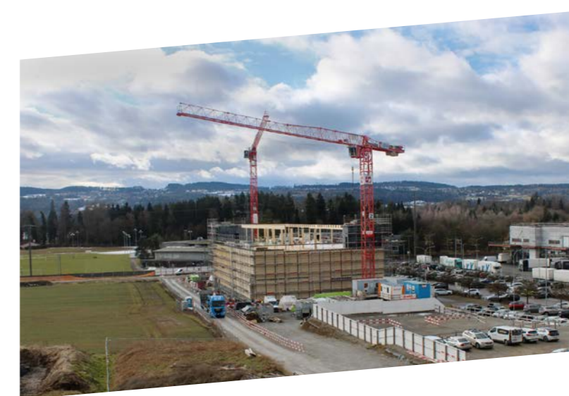
Bau Energiezentrale Volketswil (Bild: Energie 360°)
