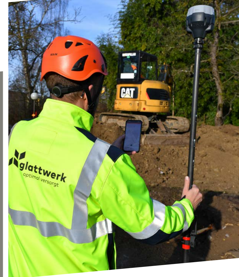
GIS Digitalisierung – Netzdokumentation mittels Smartphone
