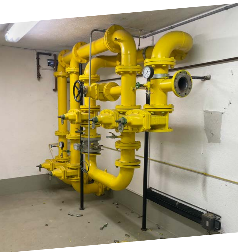
Rückbau DR-Station Schwimmbad
